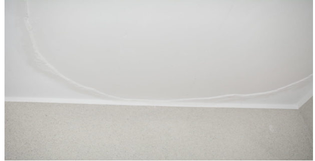
Putzschaden Treppenhausdecke
